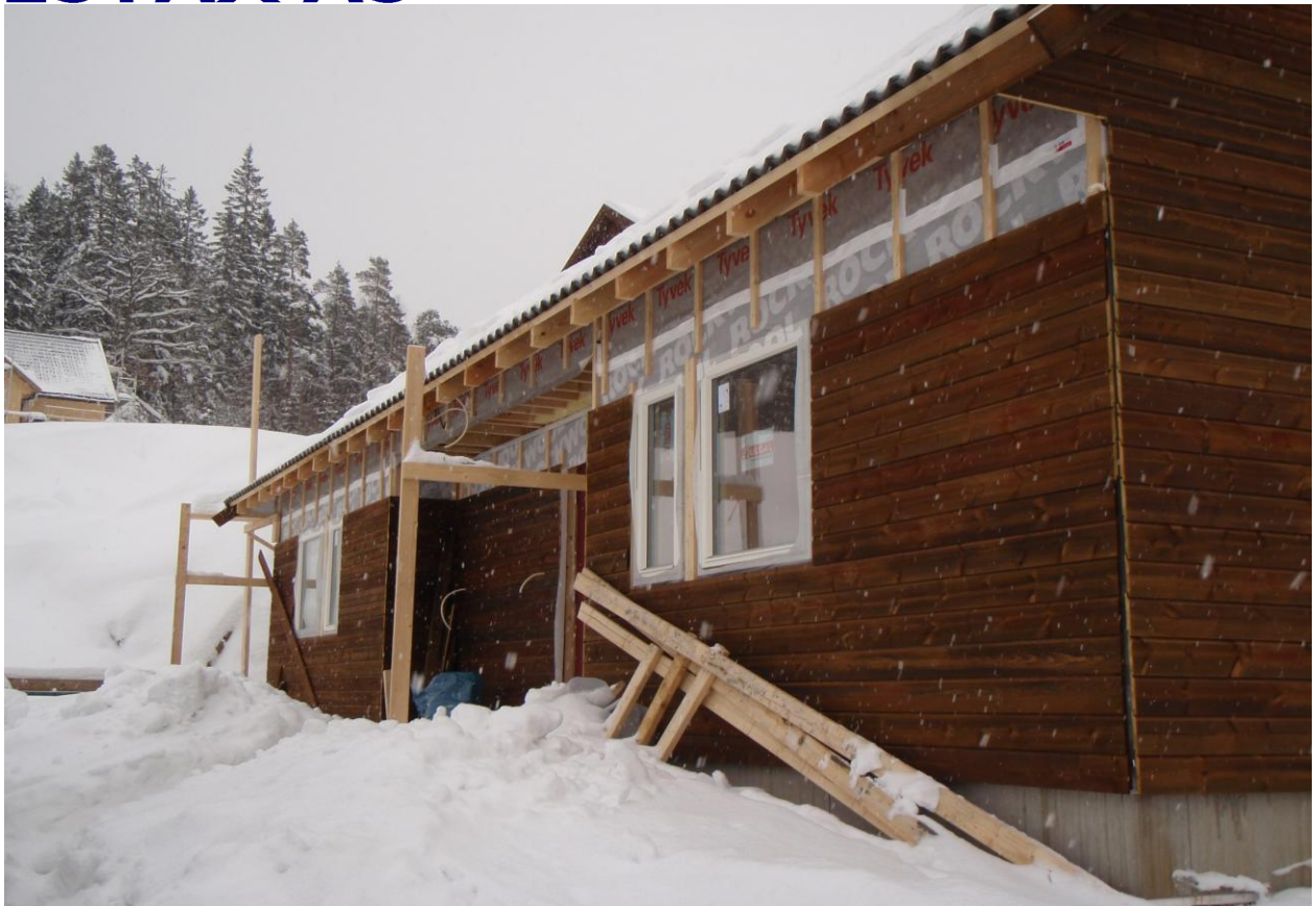
Kledning er under arbeid. Taktekking i hovedsak ferdig
